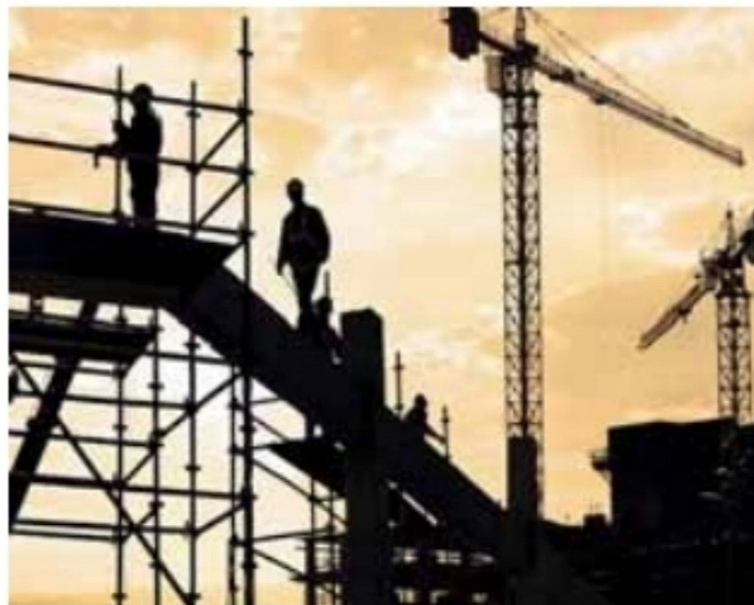
●●●● LAVORI Operai al lavoro in un cantiere
